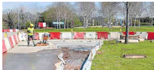
Trabajos de urbanización en los terrenos de la Pecuaria. J. M. PARDO
